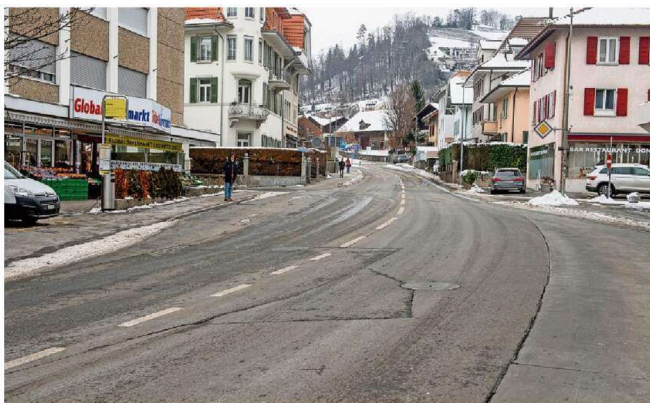
Die Steffisburgstrasse in Thun: Hier werden die Kanalisation erneuert und ein Geh- und Veloweg erstellt.
