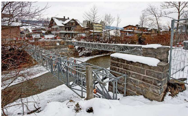
Die alte Zulbrücke in Steffisburg: Sie wurde bereits abgerissen. Fotos: Patric Spahni
