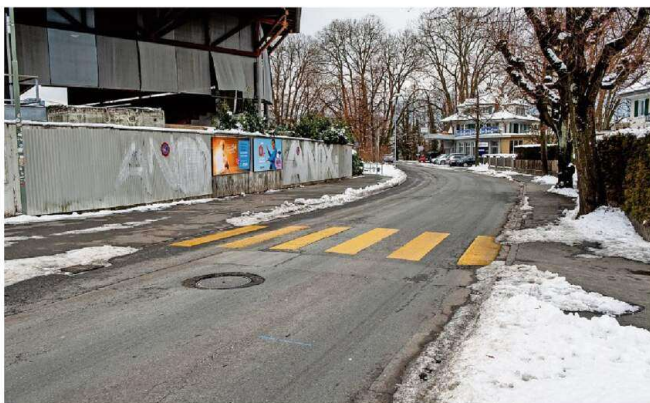
Die Kyburgstrasse in Thun: Auch hier muss die Kanalisation ausgebaut werden.
