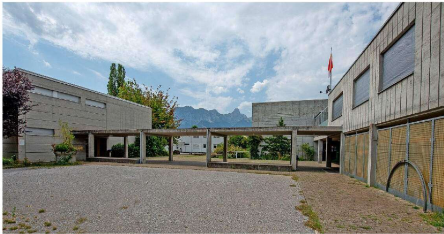
Die Schulanlage Oberstufe Strättligen soll saniert und erweitert werden. Dafür hat der Stadtrat gestern Abend Geld gesprochen. Foto: Patric Spahni
