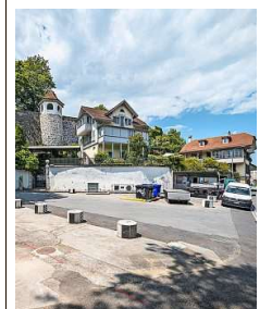
Die Stadt Thun beginnt heute mit dem Umbau des Schlossbergplatzes. Foto: Christoph Gerber
