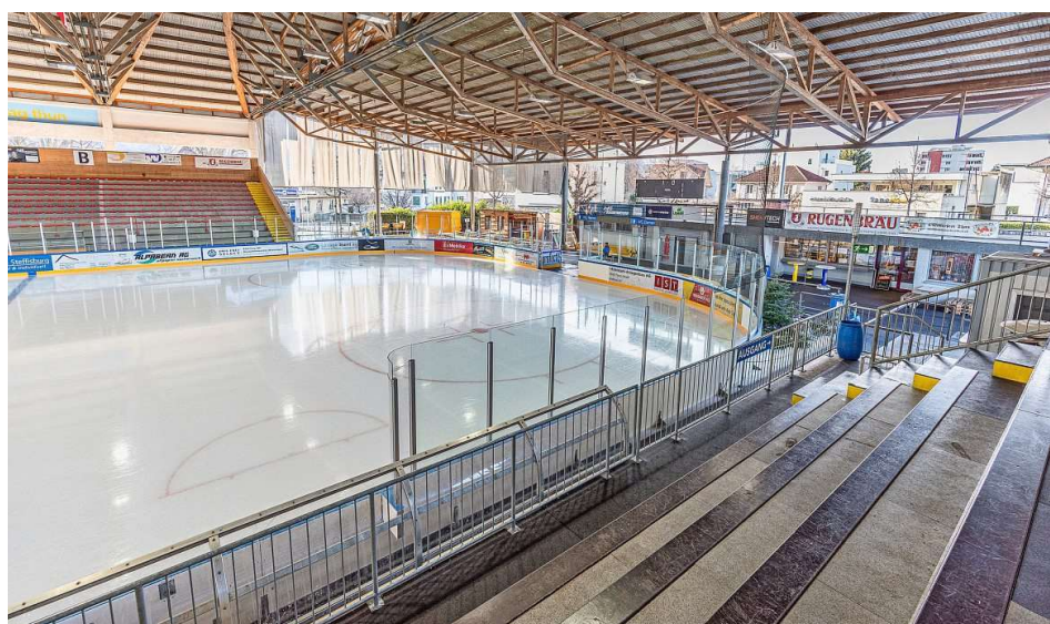
Wegen trotz der Neuausschreibung der Arbeiten alles rundläuft, sollte das Grabengut auf die Wintersaison 26/27 saniert sein. Foto: Christoph Gerber
