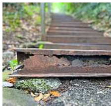
Die Eisenschwellen werden bei der Sanierung der Treppe ersetzt – mit einer Stellplatte aus Stein.
