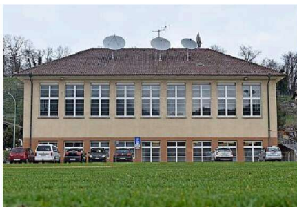
Die 1935 erbaute Turnhalle Seematte wird saniert und erhält ihre ursprüngliche senfgelbe Farbe zurück. Foto: Jürg Spielmann
