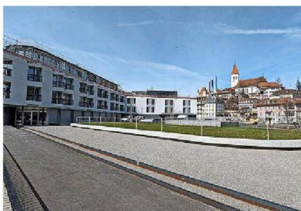
Viel Grau – wenig Grün: Die Stadtoase auf dem Vorplatz des Hotels Aare Thun (ehem. Freienhof) wurde stark kritisiert. Foto: Marco Zysset
