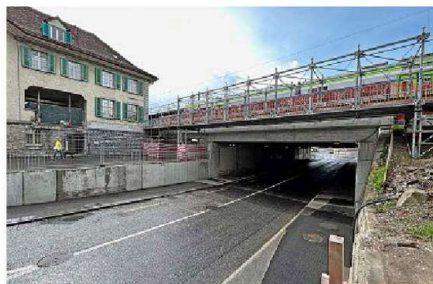
Hier fehlt eine Brücke. Das Milchbrüggli wird neu gebaut. 2025 soll das Trottoir links im Bild einer Bus- und Velospur weichen. Foto: Michael Gurtner
